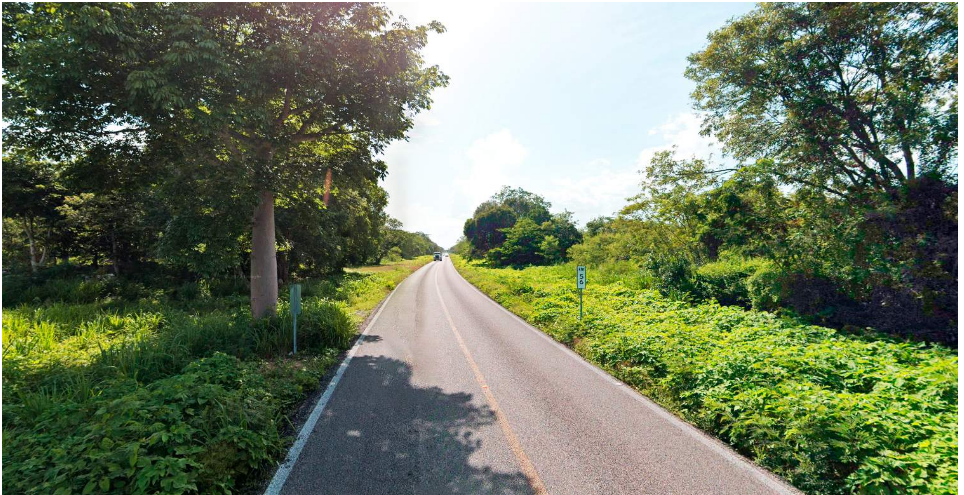
CARRETERA DE ACCESO
