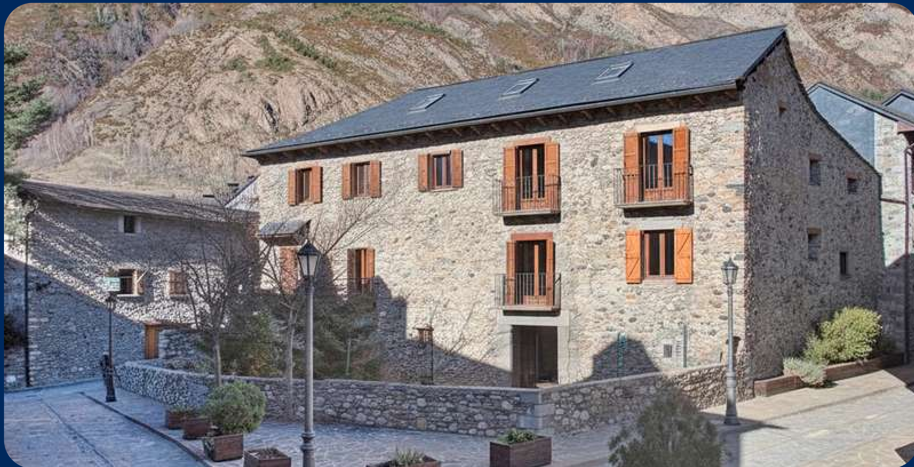
IMAGEN REPRESENTATIVA FACHADA (TRAS FINALIZACIÓN PODRÍA VARIAR)
